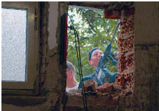
Horch was kommt von draußen rein. Mit dem Pressluftmeißel geht es leichter.
