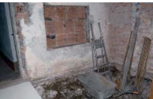
Das ehemalige Millikammerl wird in's Bad Niederbreitenbach mit einbezogen.
