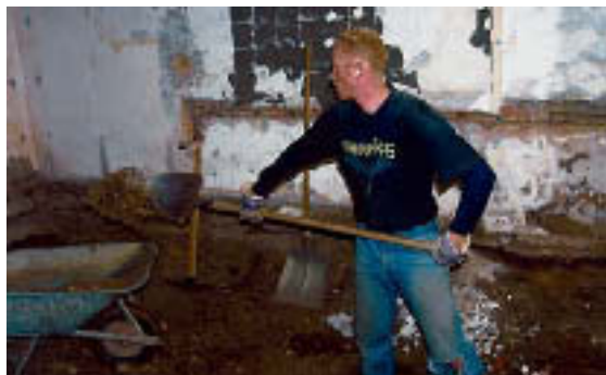
Der Aushub nimmt kein Ende. Rund 16 Kubikmeter kommen da zusammen.
