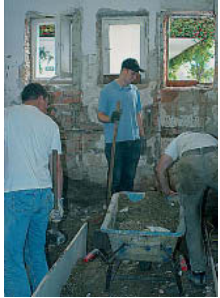
40 cm müssen wegen der Isolierung ausgehoben werden. Das sind allerhand Kubikmeter mit extra grobem Gestein.
