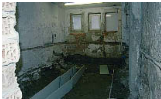
Der Aushub ist geschafft. Der Schacht für die Kanalisation musste insgesamt 80 cm tief werden.
