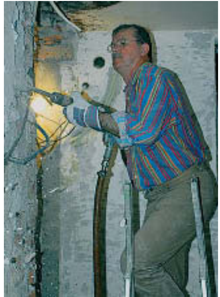
Der alte Verputz muss restlos runter.
